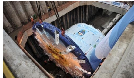
Imagen N°4: Máquina tuneladora, una TBM (Tunnel Boring Machine) importada desde Alemania (Fuente: http://www.transporte.gov.ar ).
